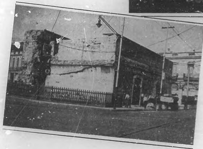
Otro de los restos de las murallas, situado frente a la Estación Terminal.
