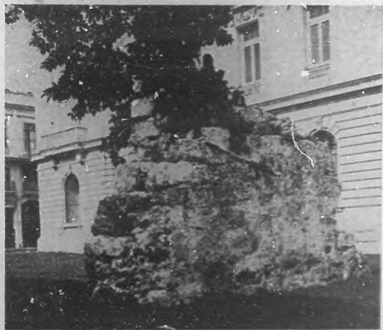
Contrastando con los edificios modernos del Instituto, destaca este pequeño y en ruinas resto de las murallas habaneras.
